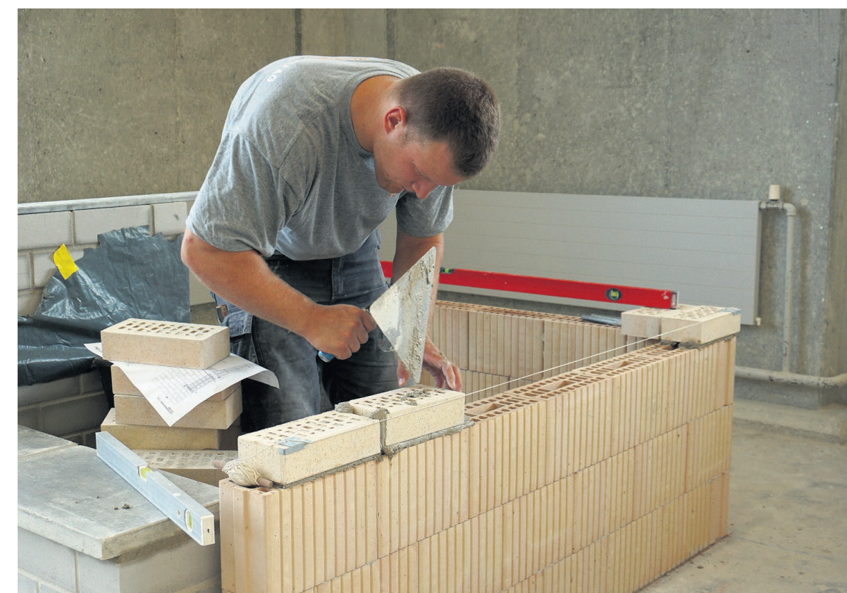
Mithelfen beim Bau der längsten Mauer der Zentralschweiz.
