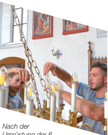
Nach der Umrüstung der 6 Kronleuchter mit je 24 Lampen auf die neuen dimmbaren LCC-Leuchtmittel können bei gleichbleibenden Betriebsstunden **über 90% Strom eingespart** werden. Die Mehrkosten für die Leuchtmittel werden dank der immensen Energieersparnis und der längeren Lebensdauer nach kurzer Zeit amortisiert.
